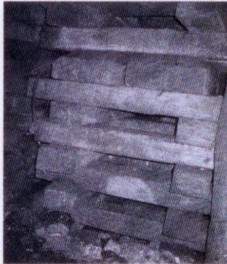
Şekil 3 Üretim ayağında kurulan yeni ön gerilmeli domuzdamı( Nisan-2007)
