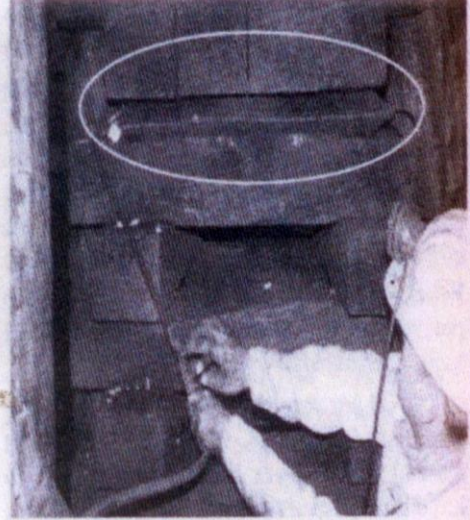
Şekil 10f. Bağlantı elemanın yardımı ile sisteme basınçlı hava verilerek şişirilmesi (domuz damının aktif hale geçmesi).
